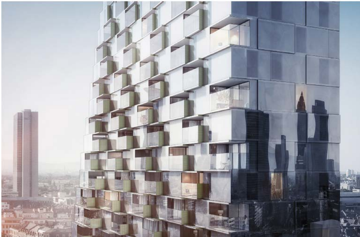
Die Funktion bestimmt die Form: Loggien werden in der Höhe zu windgeschützten Wintergärten.
